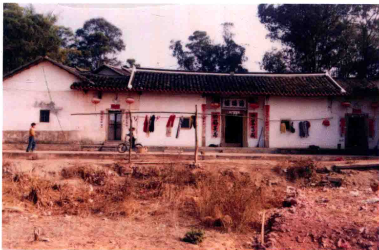
浩德楼祖屋于1998年修缮后
