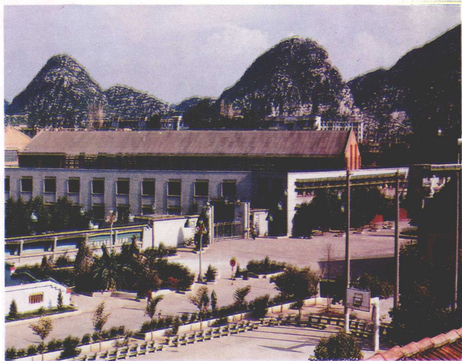
柳州第二空压机厂工厂前区
