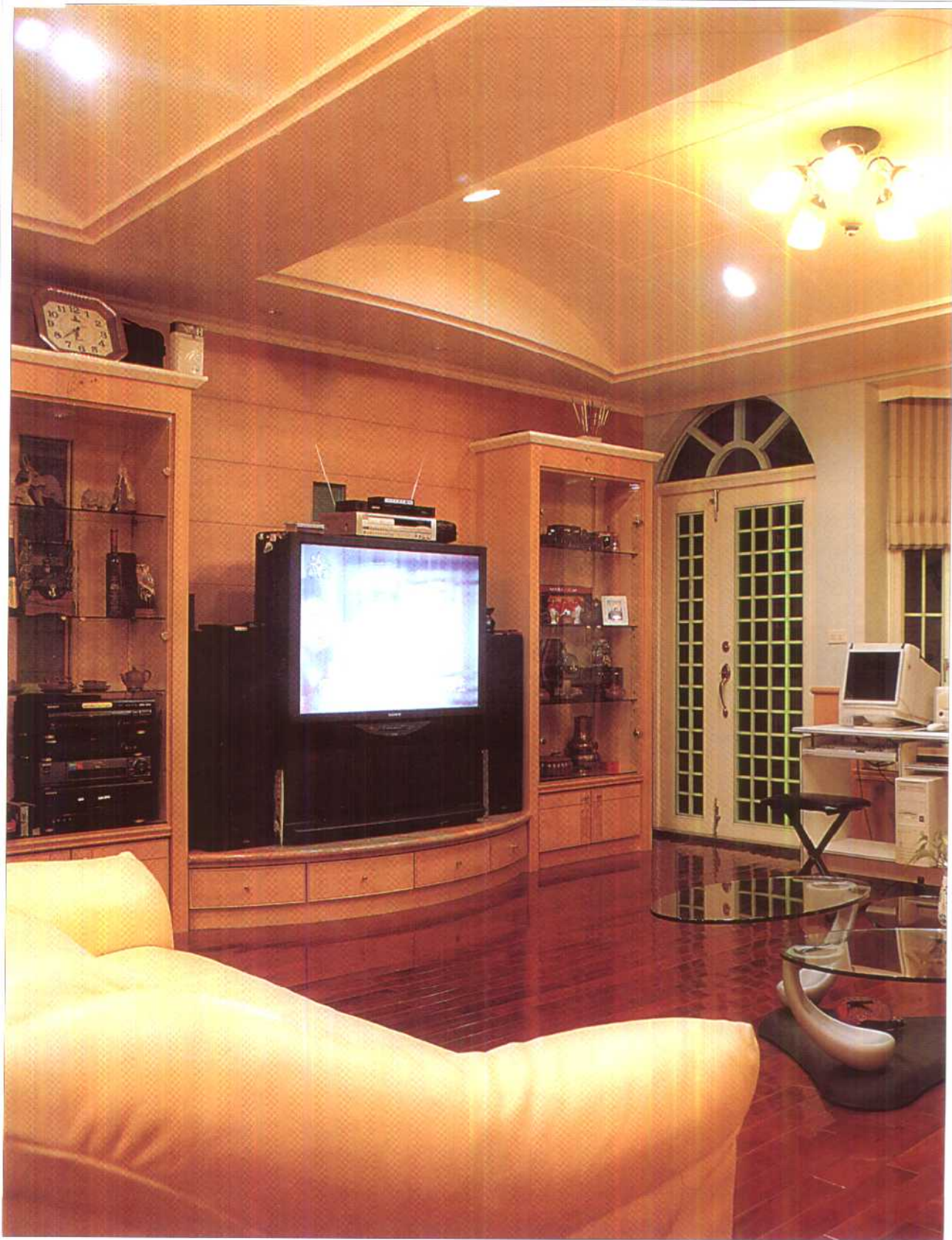
大梁压顶的天花以弧形造型作沟缝处理，不仅消除压抑感，并且美化空间。
