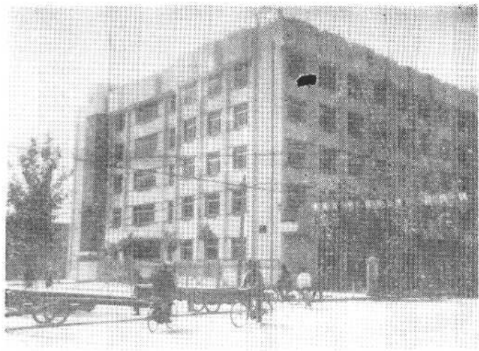
周口市工商管理局办公大楼
