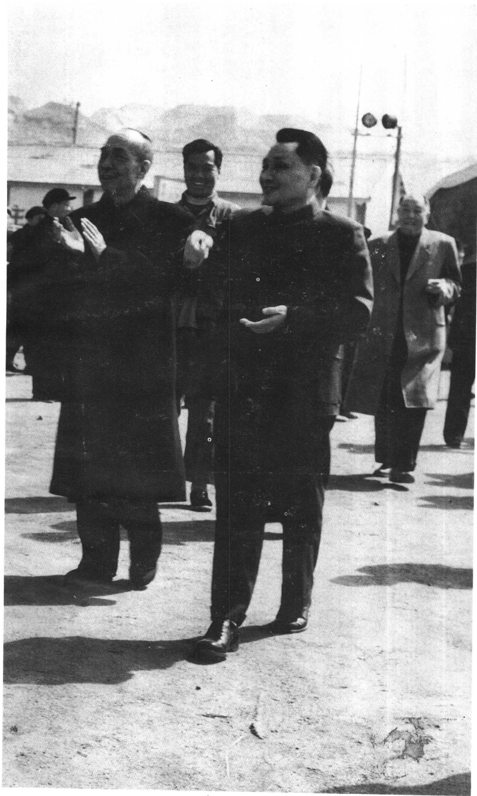
1964年，国务院副总理邓小平、李富春视察刘家峡水电站建设工地。
