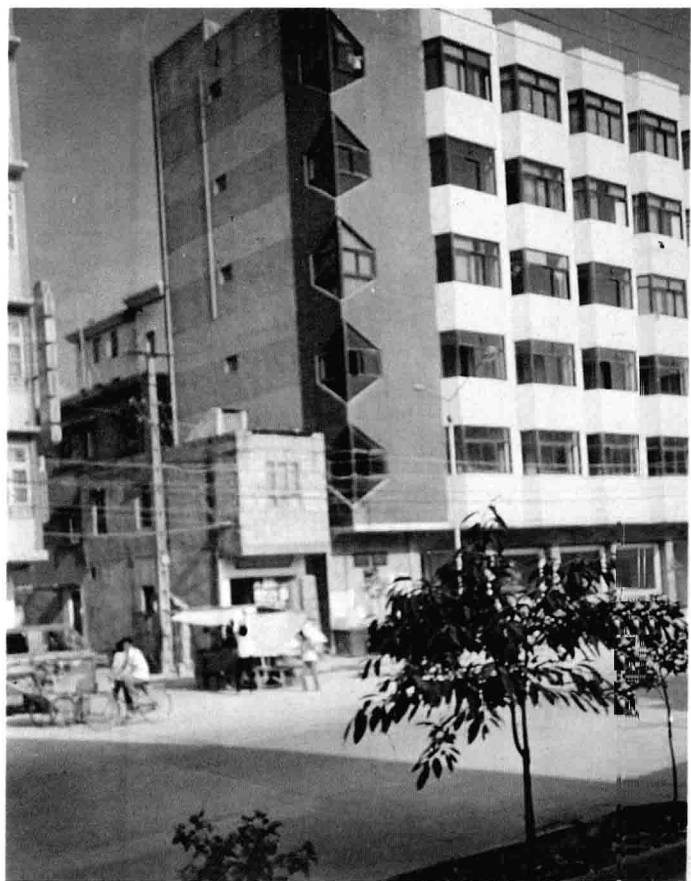
丰顺县人民政府侨务办公室办公大楼
