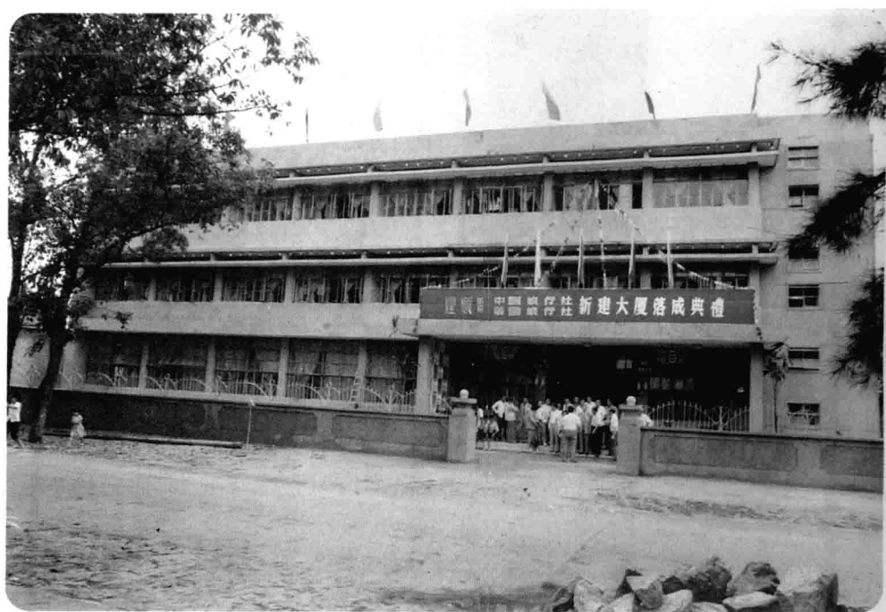
一九八一年五月落成的 丰顺县中国旅行社大楼
