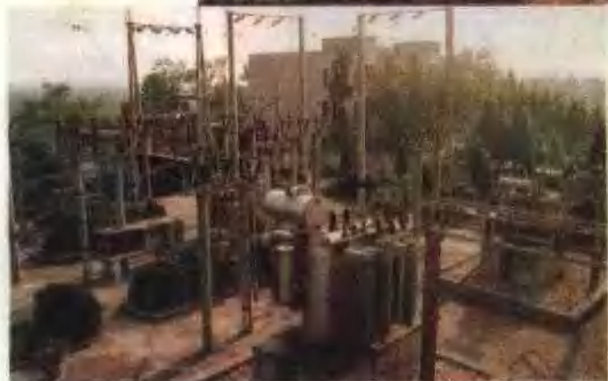
◁1987年建成的水洪输变电站，装机容量为 8700KVA。
