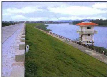
全区现有堤围59宗，堤长221.59公里，捍卫面积17.25万亩，人口25.33万人。90年代进行了堤围加固达标建设，区内主要江河、珠江西航道、白坭河、新街河等干流大堤已完成了高标准达标建设，堤面宽6至8米，可通行汽车，大堤安全稳固，防洪标准分别达到100年一遇、20年一遇。流溪河大堤正在分期进行整治。全区已完成堤岸整治32公里，按100年一遇的防洪标准设防。
