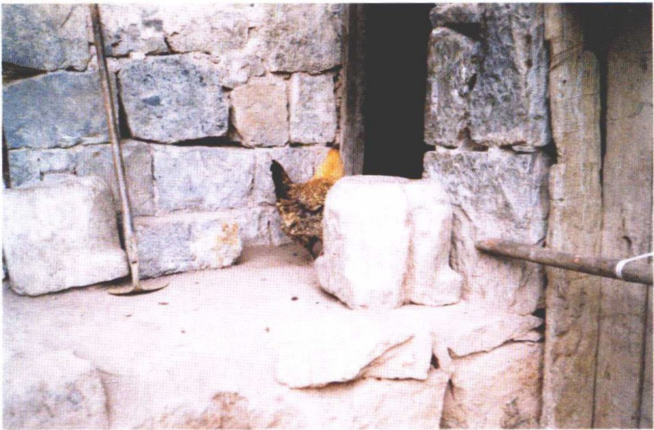
巡抚檐柱石墩
