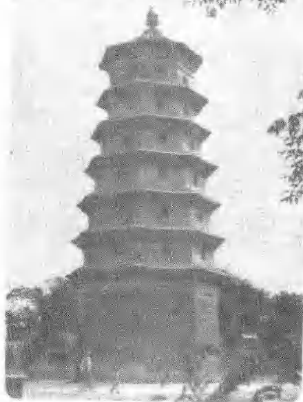
西溪海春轩塔
