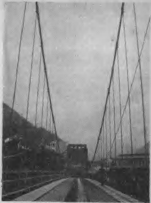
大渡河钢索悬桥
