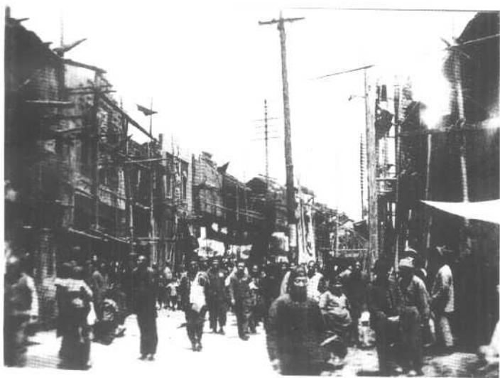
◀泰州城区解放后，市委市政府即着手规划市政建设。图为正在首次拓宽改造中的大林桥至扬桥段。
