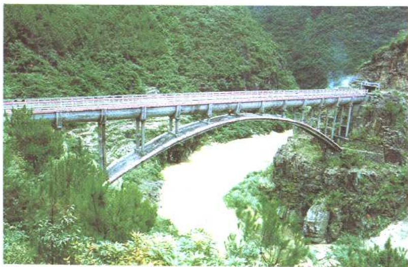
坑口四级站渡槽
