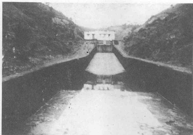
马山水库泄洪闸
