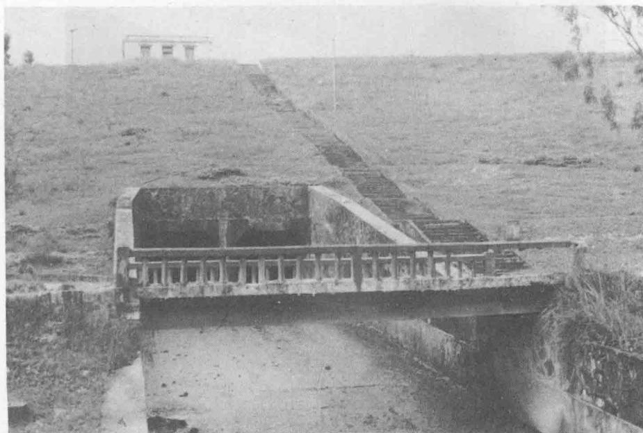
良西水库泄洪洞
