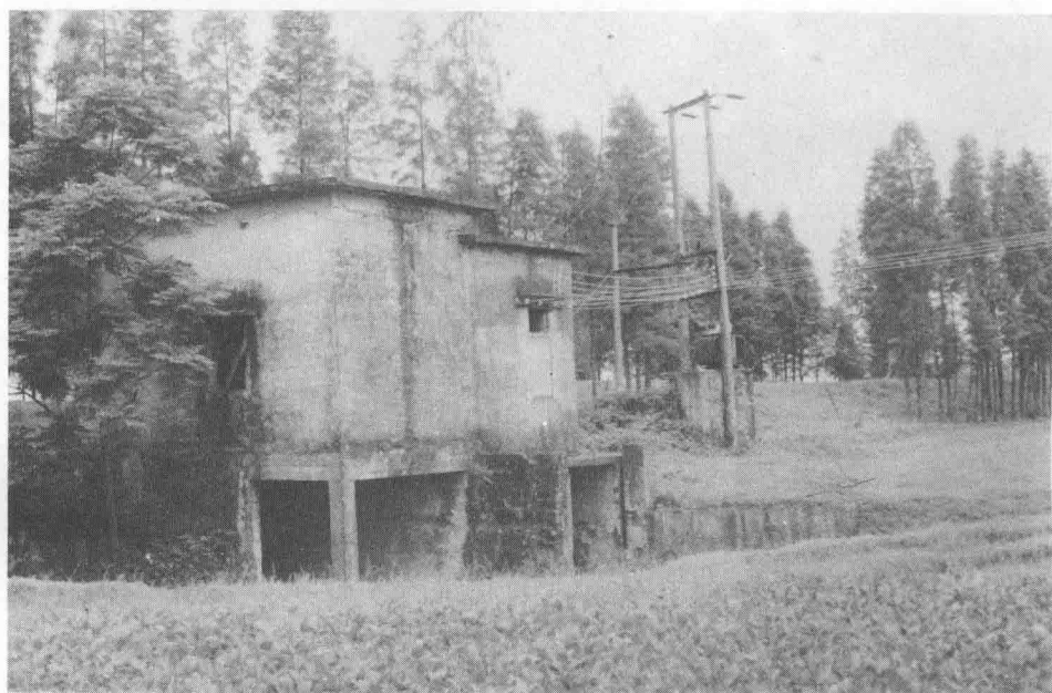
金贵围电排站
