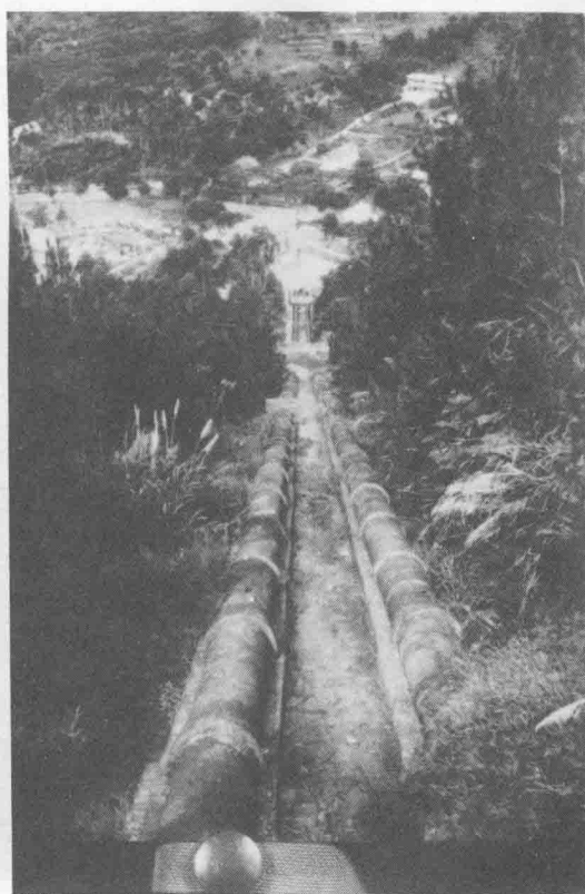
大带电站第三级电站及压力管
