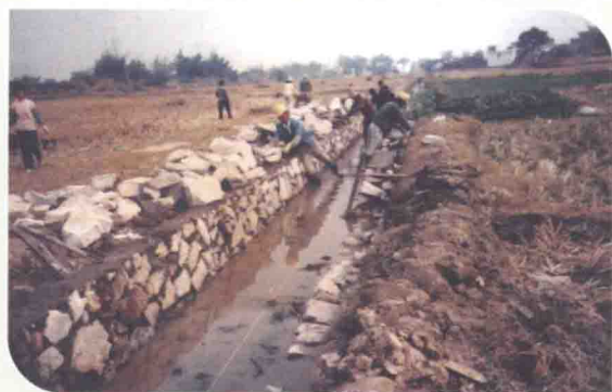
实施中的“大禹怀”水利工程
