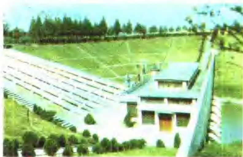
▲ 为百里长渠补充水源的轆河泵站
