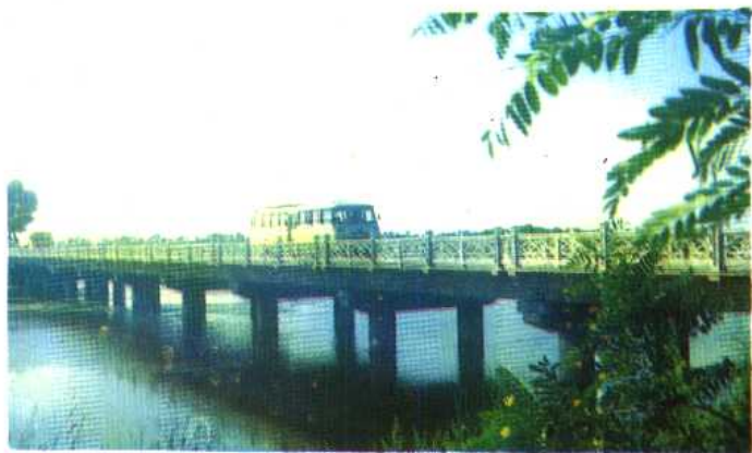
1976年地震后新建的唐柏路曾家湾大桥（位于北侧）
