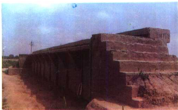
一农场下水门：原日伪时建立，已废， 解放后建有新闸
