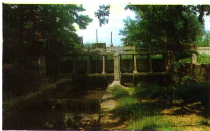
东灌区分水闸：原日伪建，解放后扩建。
