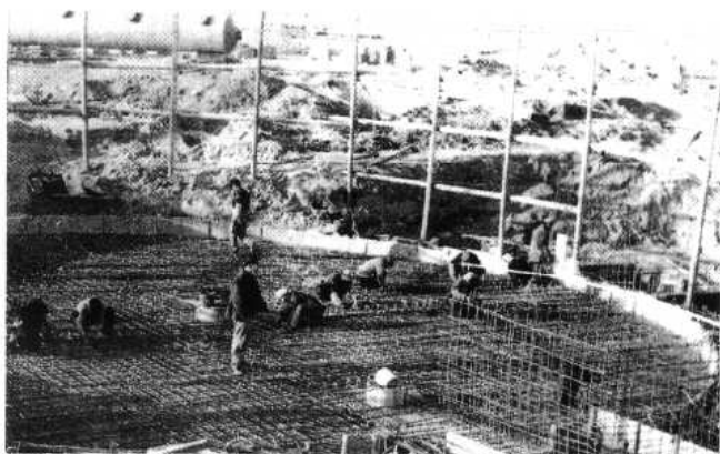
柏农化肥厂创建时的施工情况 1959年
