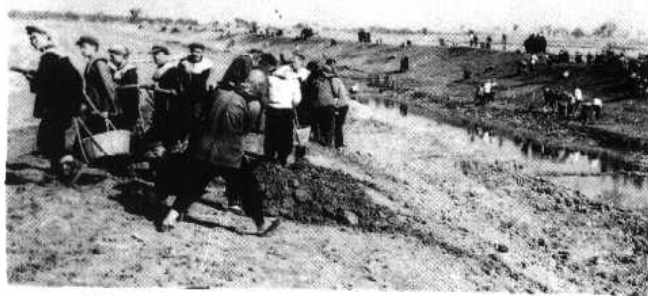
柏各庄农场开创时期水利施工现场
