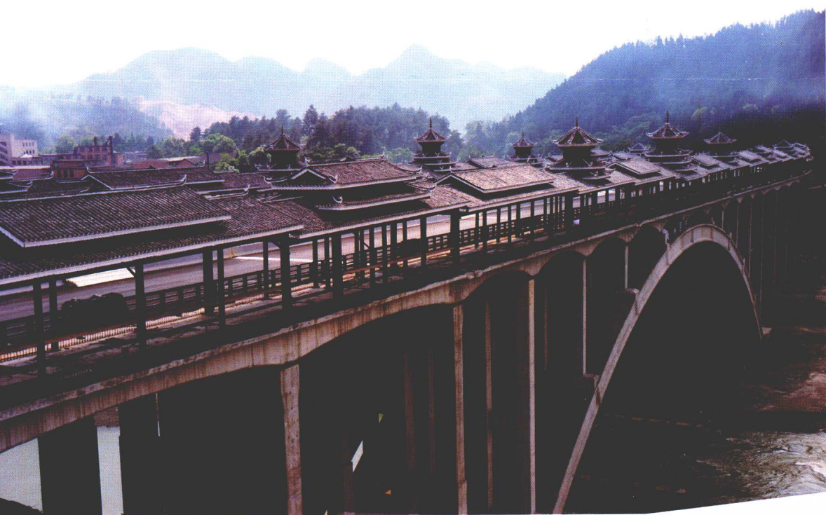
凯里清水江风雨桥总投资3亿多元，全长377米，宽44米，主拱跨度150米，成为当今世界最长最宽的风雨桥。
