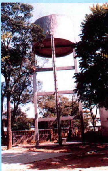
南口中学自来水塔及引水设施，工程总造价为15万元。
