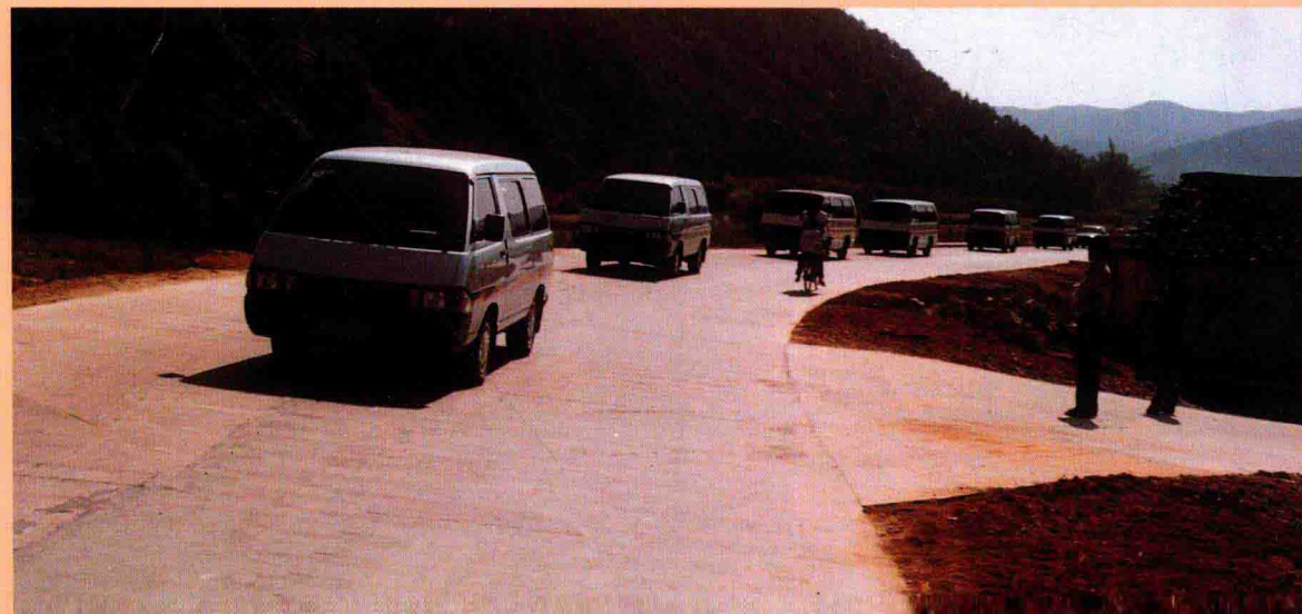
梅瑶公路第一期工程竣工剪彩后, 车队 鱼贯通过宽阔平坦的水泥公路
