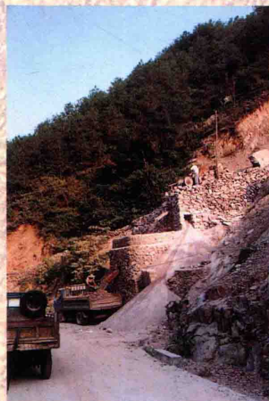
葵黄管理区建筑石场
