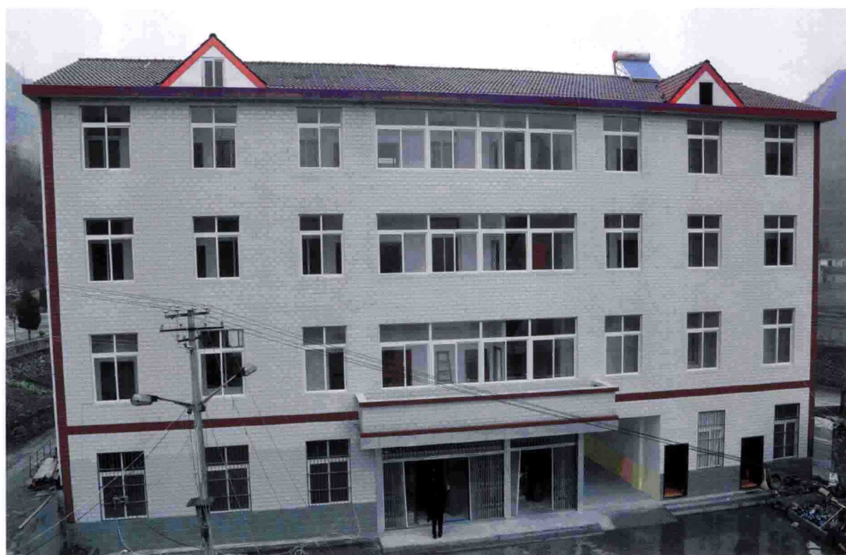
▲新建向坝乡文化、计生、教育综合楼。
