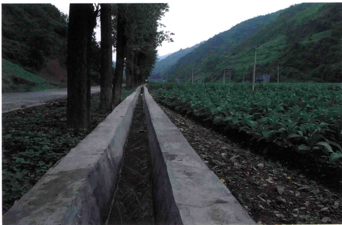
▲实施“烟水”配套项目建设,新修灌溉渠 4 公里。
