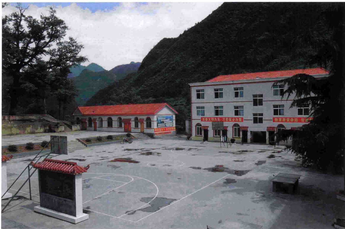
▲海南三亚众城国际客运旅业有限公司(现海南三亚凤凰岛投资公司)董事长曾宪云先生捐资援建的向坝中学教学综合楼。
