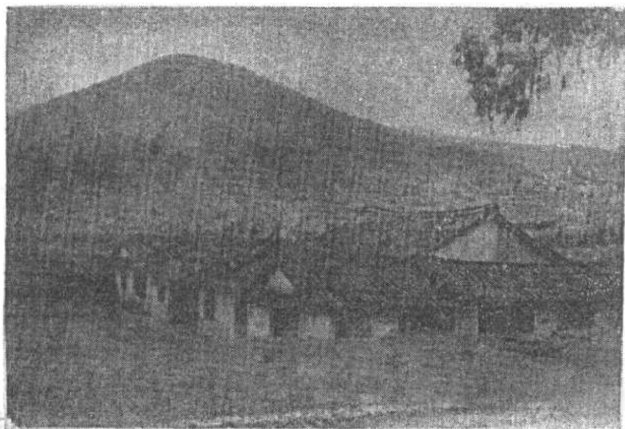
图十五 中美合作所军械库。山顶端是气象联络台，已倒塌。
