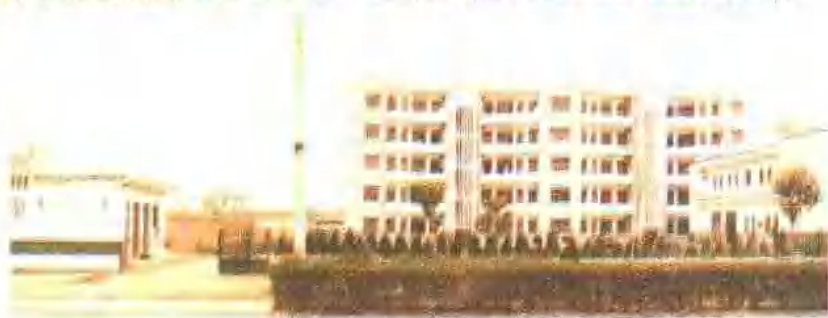
中国银行谷城支行（住宅楼）
