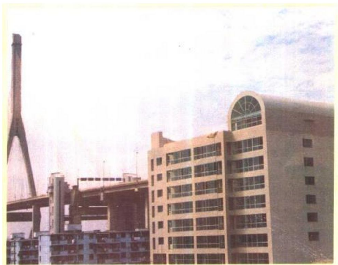
公司办公楼——祥和大厦
