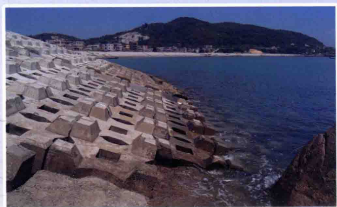
中化泉州石化和当地政府共建的杜厝海堤
