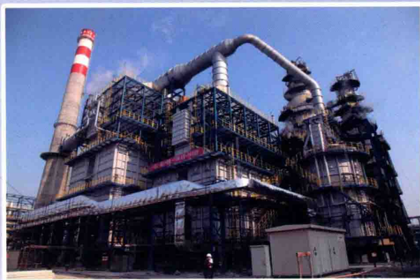
1200万吨年常减压装置
