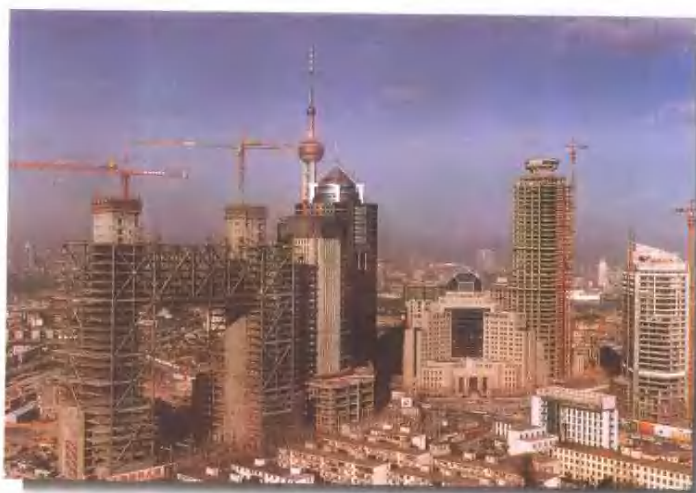
1996年4月陆家嘴路和浦东南路口的建设风貌
