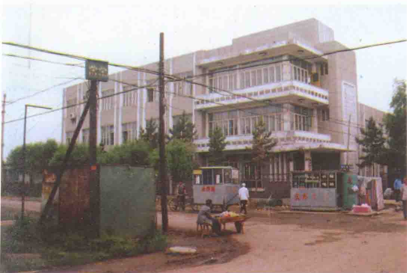
1988年，县土地管理局新建的办公楼。
