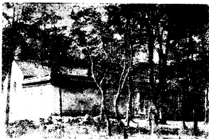
重建的“國華村舍”全景
