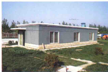
地理式污水处理站
