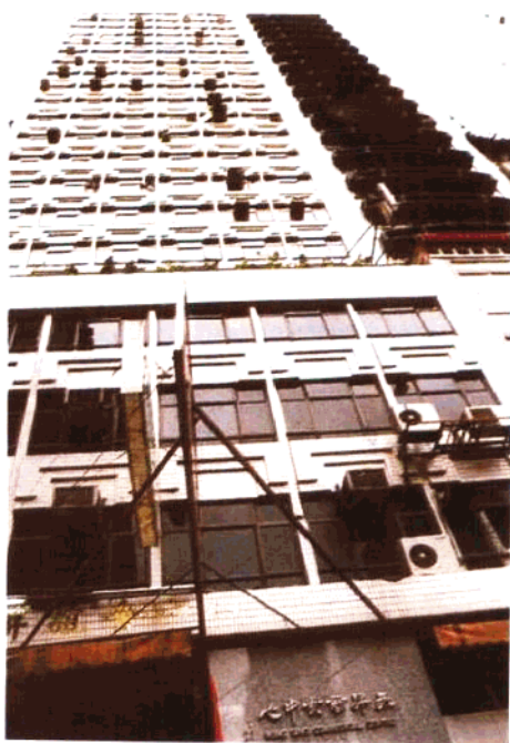
▲ 香港永樂街 12 - 16 號永升商業中心
