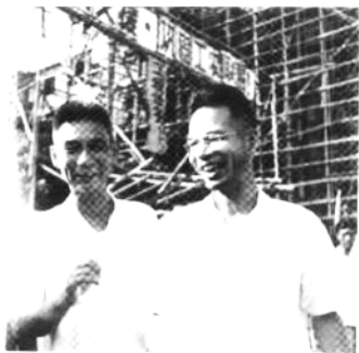
与广州海珠区区长检查水上 居民上岸基建工程 徐亮（右一） 1965年
