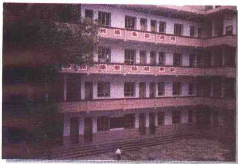
西充县第二实验小学教学大楼
