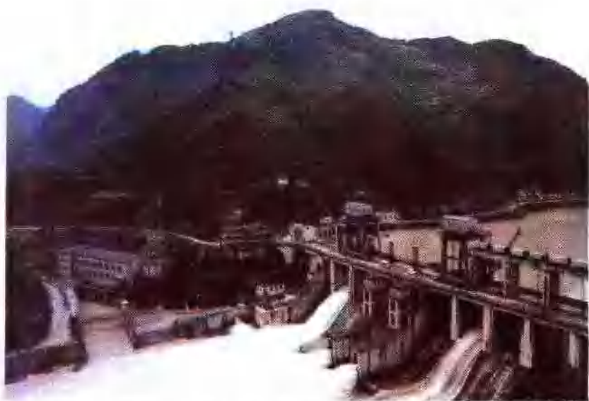
谷城南河电站大坝及发电厂房
