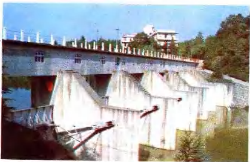
南漳三道河水库泄洪闸
