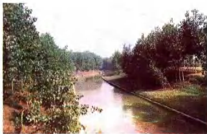
武镇长渠渠道
