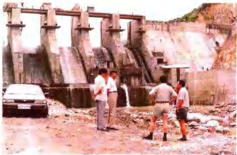
即将竣工的保康马桥一级电站挡水坝
