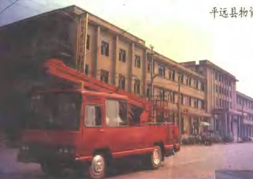
↑总公司办公（营业）大楼 钢材仓库 和堆场一角
