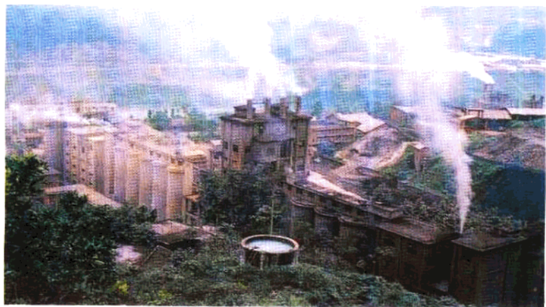
长阳水泥厂一角
