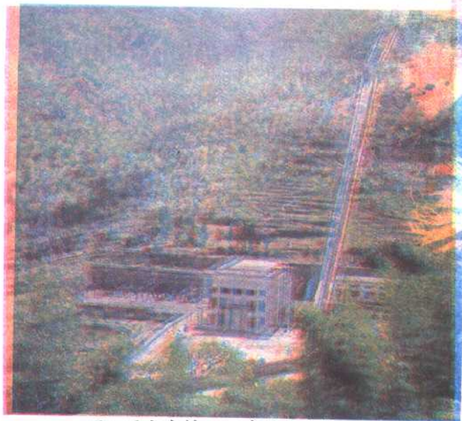
15、瑶山电站——高塘坪电站
