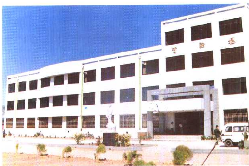
商河县第一中学实验楼
