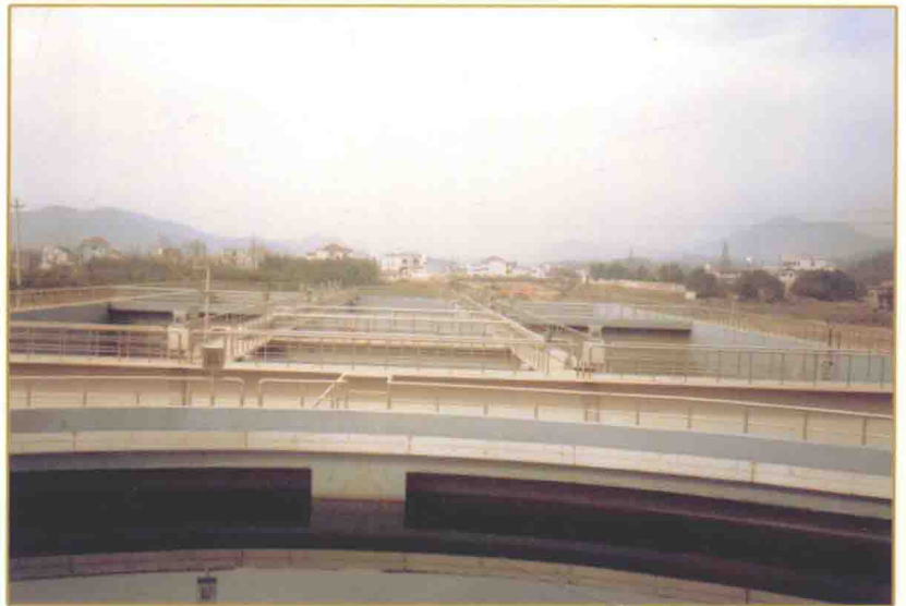
污水处理厂MSBR池
