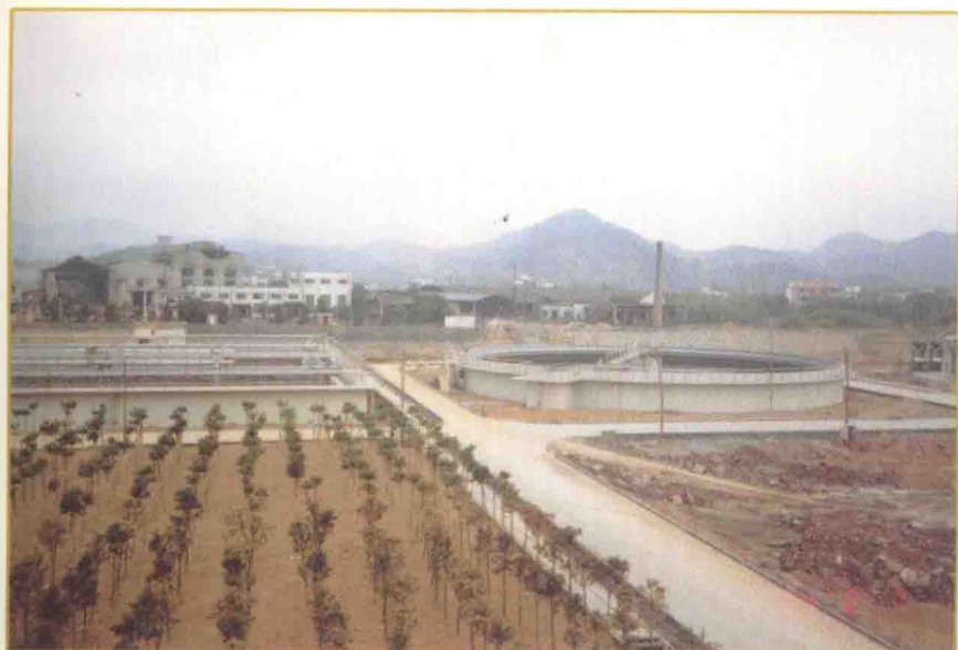
污水处理厂初沉池外景
