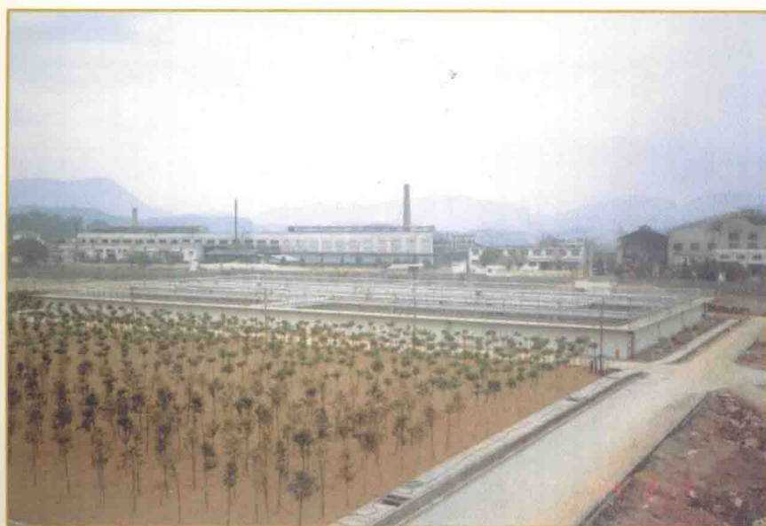
污水处理厂MSBR池外景
