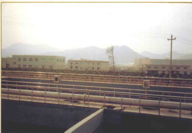
污水处理厂配套厂房外景
