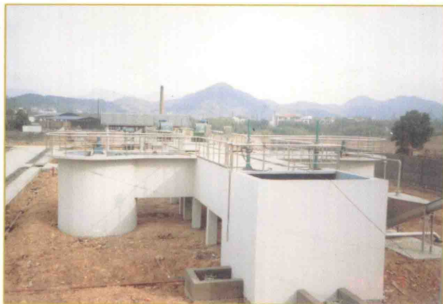
污水处理厂旋流沉砂池外景
