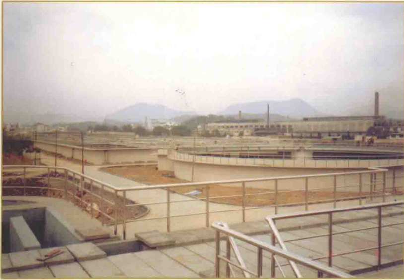
污水处理厂污水处理系统主要构筑物（旋流沉砂池→初沉池→MSBR池）
