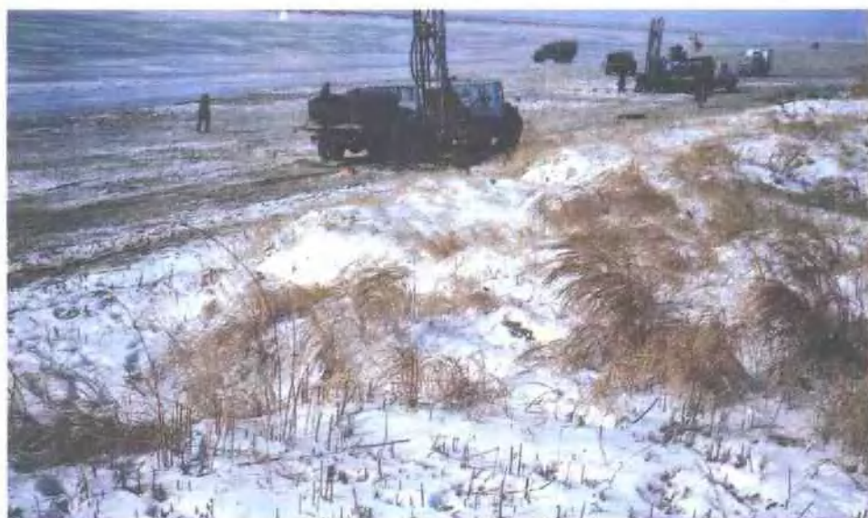
► 高寒地区施工
