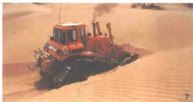
▲ 塔克拉玛干腹地施工
