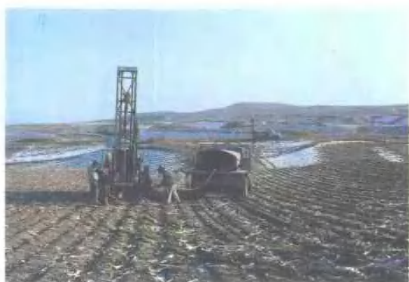
▲ 东北丘陵地区施工
