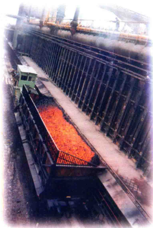
“八五”技改主体重点工程——移地大修3号65孔焦炉，1993年4月建成投产。
