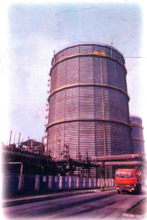
1995年11月建成的3万和10万立方米干式煤气贮柜。
