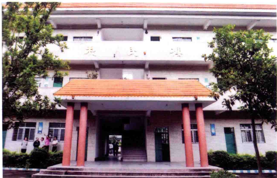
刁坊中学利民楼全貌
