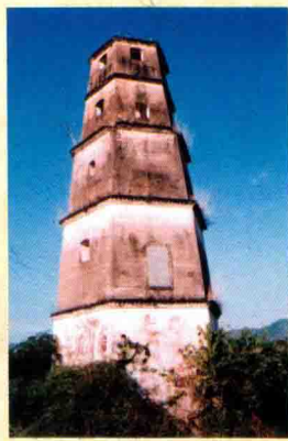
仙口塔（文魁塔）
