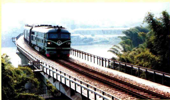
松口铁路大桥
