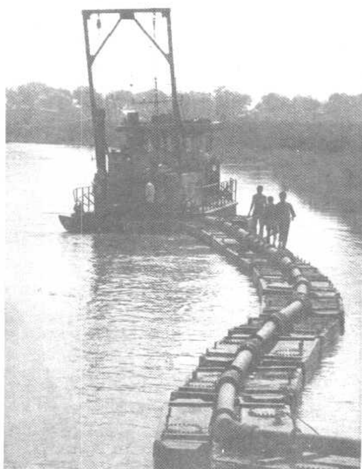
挖泥船在庄台进行喷筑施工
