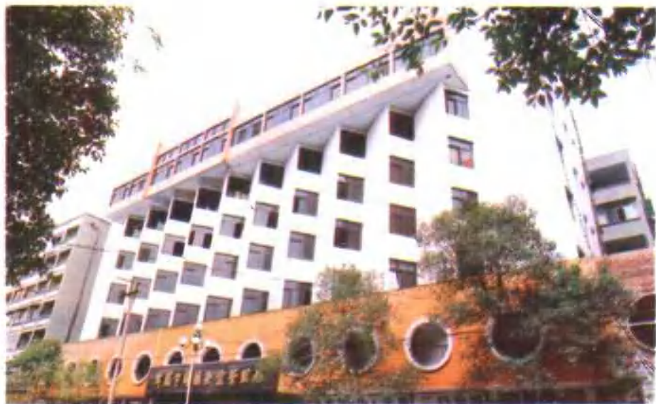
绵阳市乡镇企业管理局机关办公大楼
