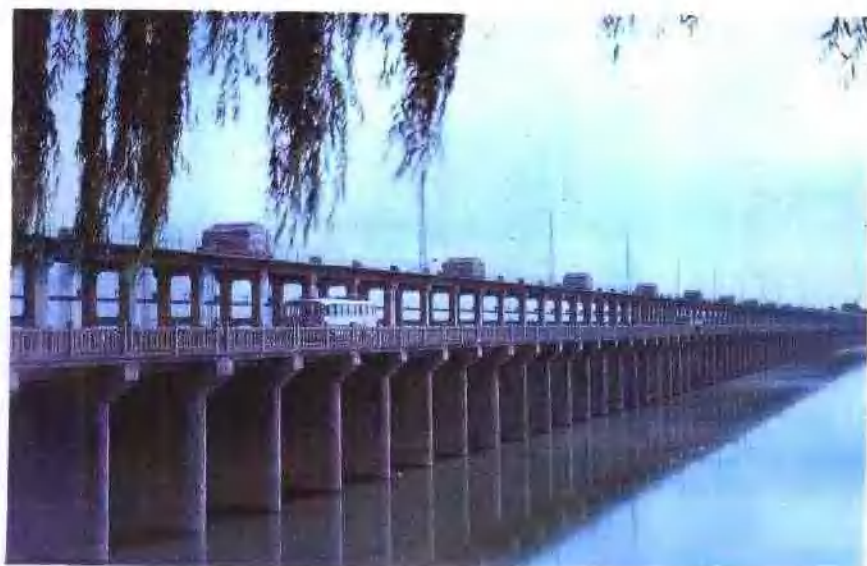
南四湖二级坝四闸
