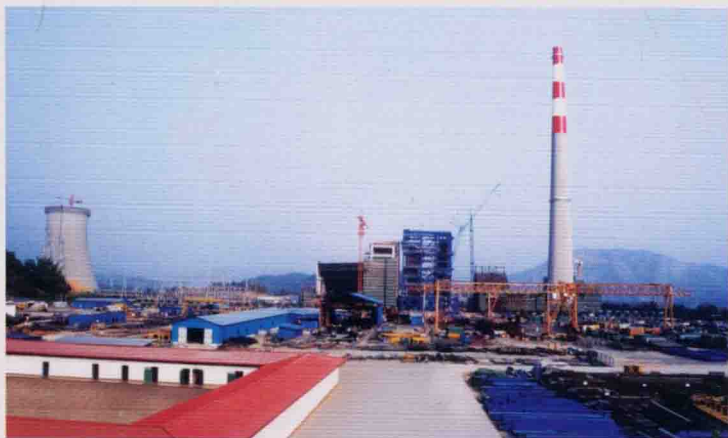
在建的总装机147万千瓦宝丽华荷树园电厂
