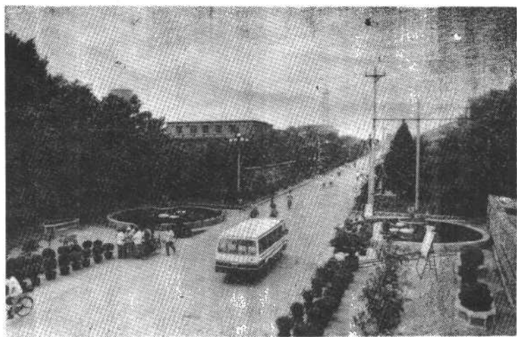
山海关桥梁厂厂区
