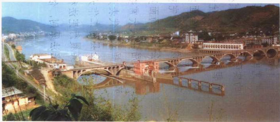
▲洋口桥、坝、电站、船闸水利枢纽工程
