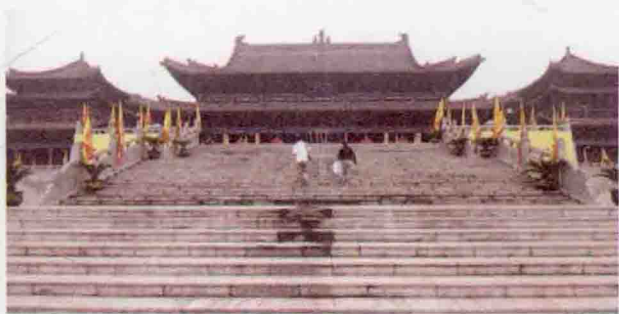
山西洪洞祭祖殿
