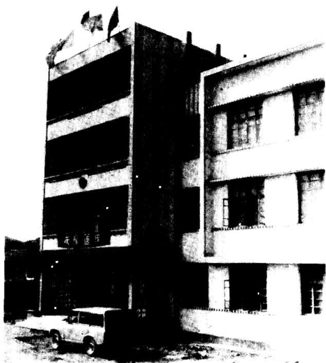
会昌县政协办公大楼
