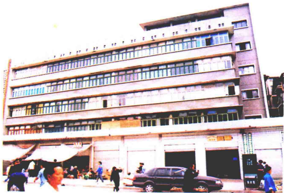
台江县烟草专卖局（公司）综合大楼。
